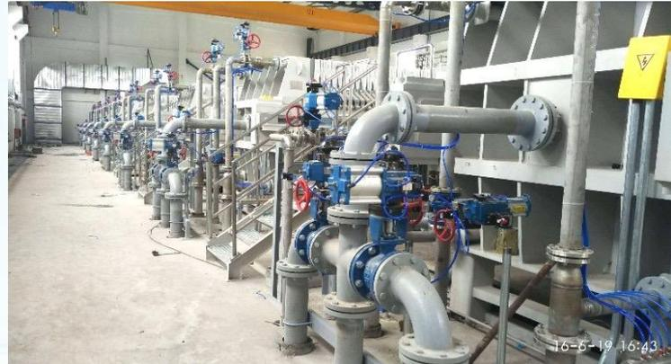
槐房再生水厂16台800平方高压隔膜压滤机
