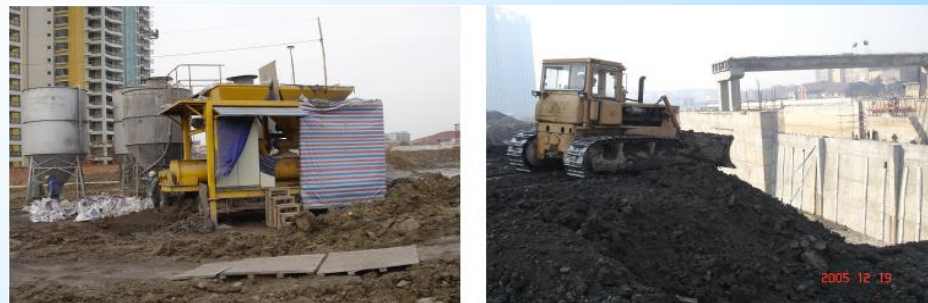
淤泥固化现场及固化土回填
