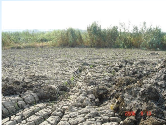
施工前长广溪850亩淤泥堆场
