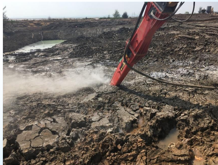
原位固化现场
