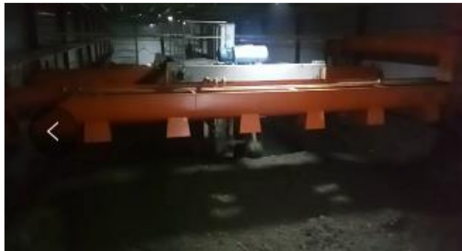
河南荥阳污泥处理项目
